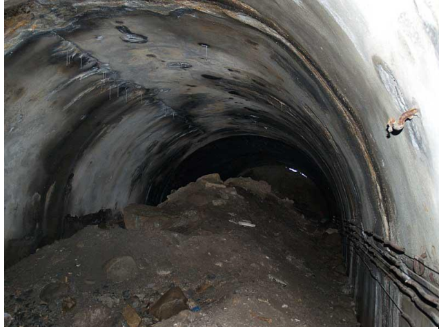
トンネル工事
